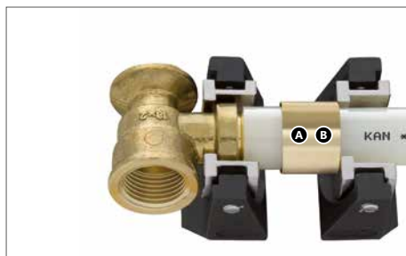
Montaż podejść do baterii mosiężnych
