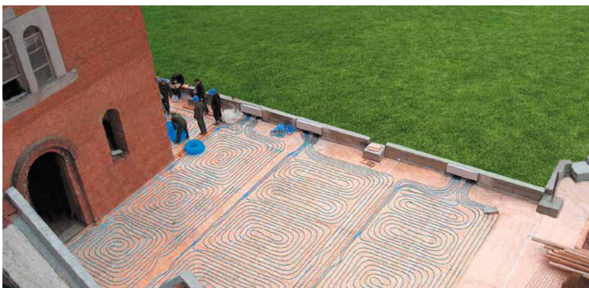
Рис. 5. Система підігріву відкритих зовнішніх поверхонь при використанні труб bluePERT системи KAN-therm.
