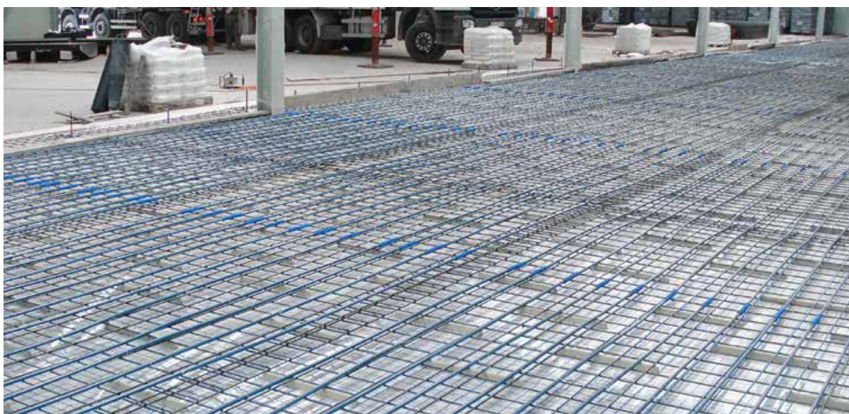
Рис. 4. Система панельного опалення в складському приміщенні при використанні труб bluePERT та системи KAN-therm NET.
