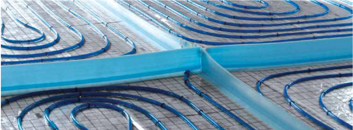
Рис. 14. Поділ поверхні демпферними швами.
