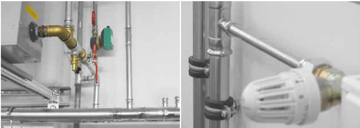
Приклади монтажу системи KAN-therm Steel
