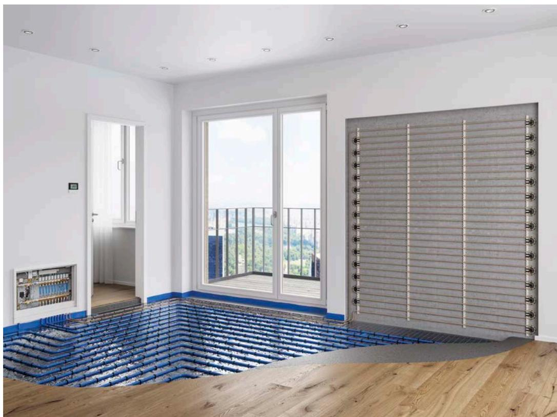
Система KAN-therm предлагает большой выбор вариантов крепления греющих труб, позволяющих конструировать разные типы подпольных и стеновых отопительных приборов, реализуемых как мокрым, так и сухим методом.
