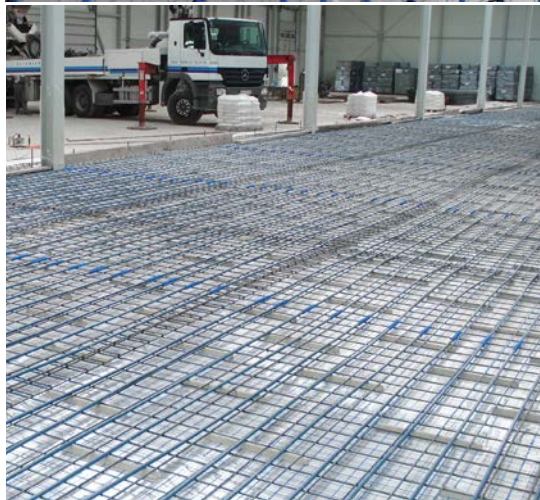
Рис. 4. Система панельного отопления в складском помещении при использовании труб PE-RT Blue Floor и системы KAN-therm NET.
