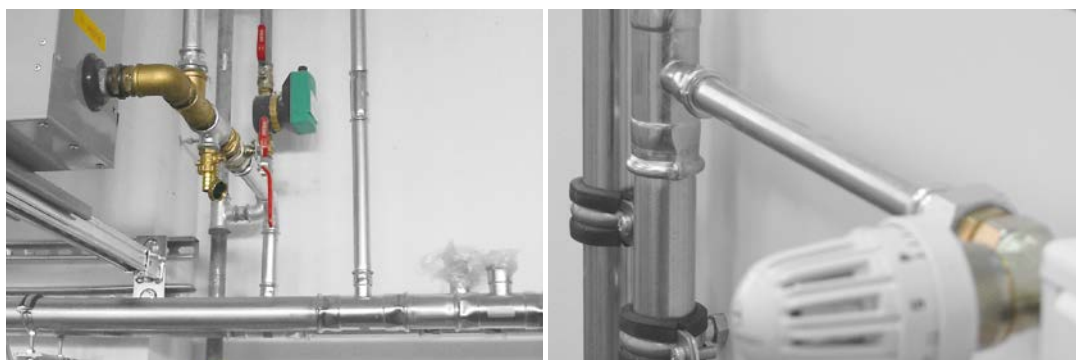
Примеры монтажа оборудования KAN-therm Steel
