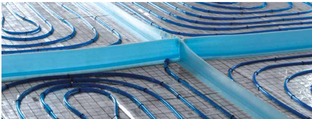
Рис. 13. Деление греющей поверхности разделительными швами
