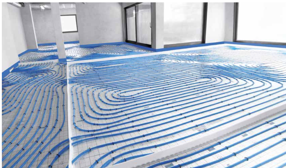
Рис. 24. Подпольное отопление, выполненное в системе KAN-therm Tacker
