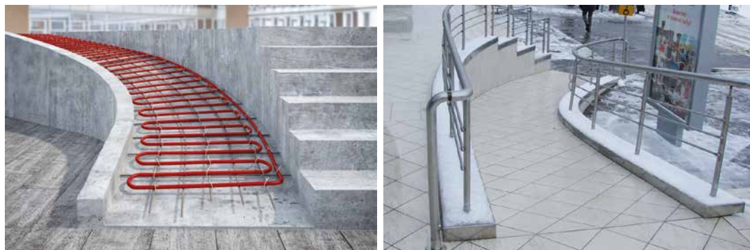
Рис. 35. Подогрев открытой поверхности Системы KAN-therm – в процессе монтажа и после окончания работ
