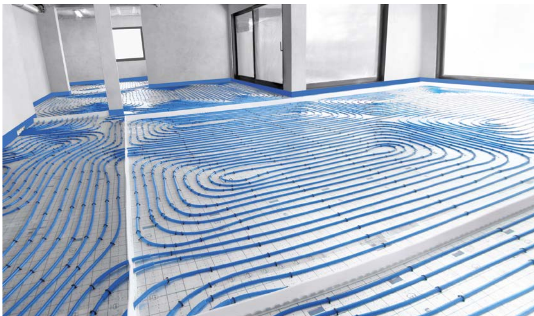
Рис. 24. Подпольное отопление, выполненное в системе KAN-therm Tacker
